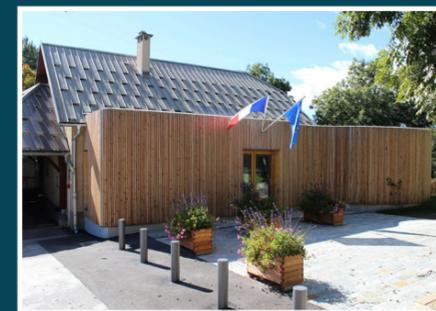
L'agrandissement de la mairie a permis d'accueillir la salle des fêtes et la nouvelle salle du conseil municipal. Le rez-de-chaussée semi-enterré est en béton, du bois certifié Bois des Alpes a été utilisé pour réaliser l'étage. Au total, 24 m<sup>3</sup> de Bois des Alpes ont été utilisés, dont 7,5 m<sup>3</sup> de mélèze pour le bardage et 16,5 m<sup>3</sup> pour l'ossature des murs et la charpente.
