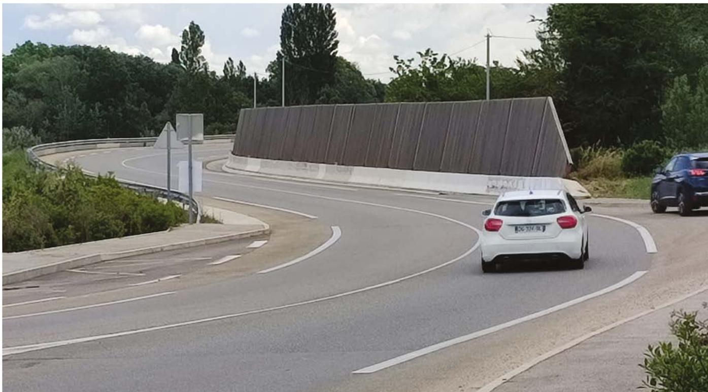
De plus en plus, le bois fait partie des ouvrages routiers. Souvent le bois utilisé est le bois de pin car celui-ci étant imprégnable, on peut l'utiliser après traitement dans des ouvrages extérieurs (classe d'emploi 3 et 4).
