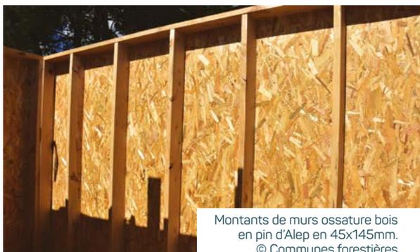
Montants de murs ossature bois en pin d'Alep en 45x145mm.
