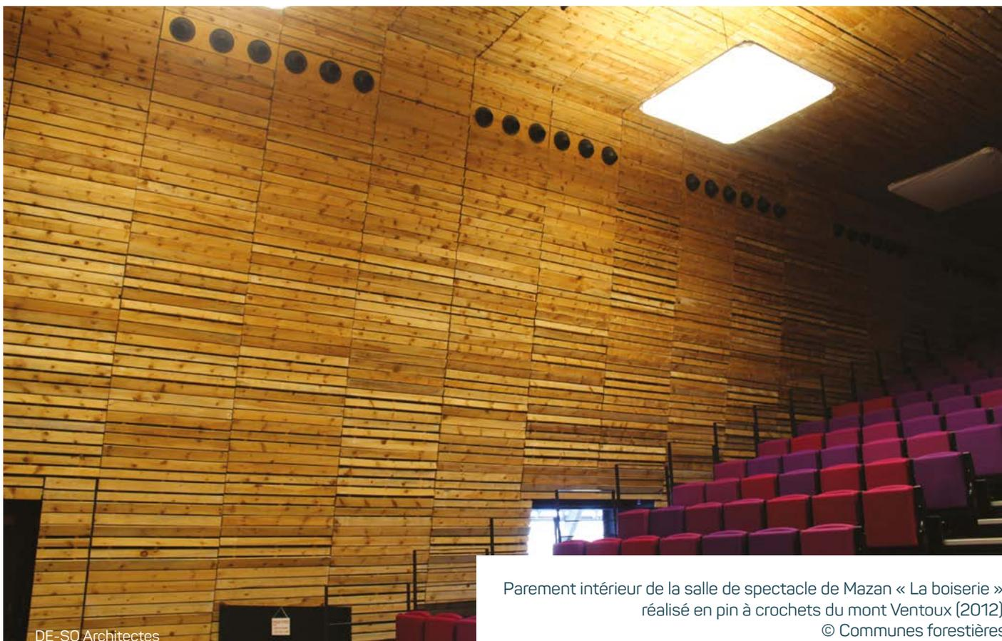
Parement intérieur de la salle de spectacle de Mazan « La boiserie », réalisé en pin à crochets du mont Ventoux (2012).
