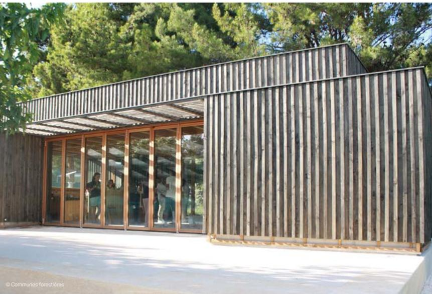
Les éléments suivants ont été réalisés en pin d'Alep : murs, charpente, façades extérieures, auvents, habillages intérieurs, mobilier.
